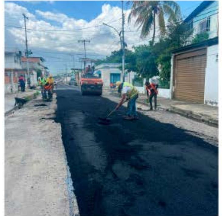
rentes sectores de la jurisdicción se han ejecutado trabajos de repavimentación en vías donde se ha hecho intervención de obras para la sustitución de tuberías de colectores para aguas servidas.
